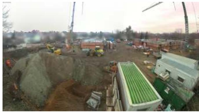
Zwei Gebäude sind bereits bis zur Erdgeschossdecke fertig gestellt. Für das dritte Gebäude laufen momentan die Fundamentierungsarbeiten.
